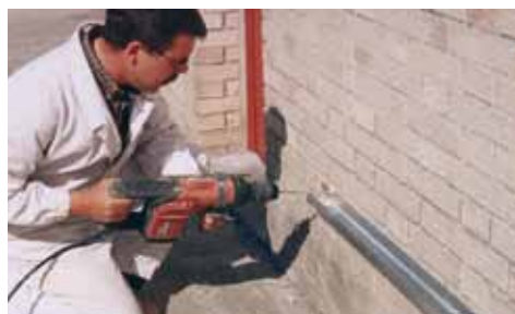
Detalle de fachada/proceso de acondicionamiento Détail de la façade/processus d'aménagement
