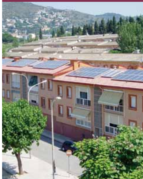
Cubiertas rehabilitadas del barrio de Pomar, Badalona, con incorporación de paneles solares térmicos y fotovoltaicos (prueba piloto) Toitures réhabilitées dans le quartier de Pomar, à Badalona, avec incorporation de panneaux solaire thermiques et photovoltaïques (essai pilote)
