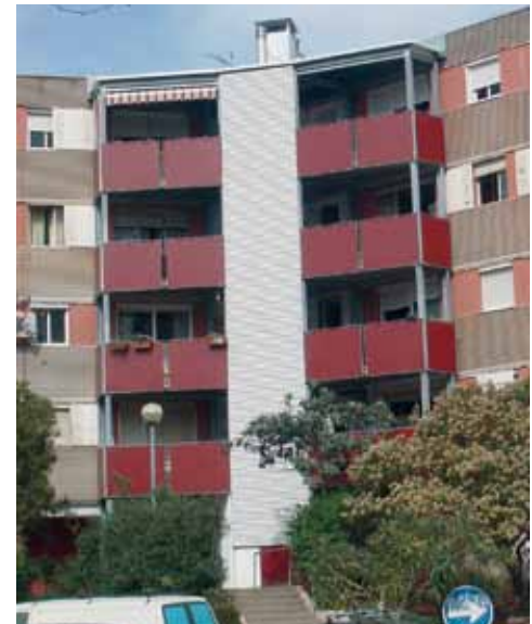
Nuevas galerías y balcones en Badía del Vallés (sustituyendo las galerías de fibrocemento con amianto) Nouvelles galeries et nouveaux balcons à Badia del Vallès (ils remplacent les galeries en fibrociment contenant de l'amiant)
