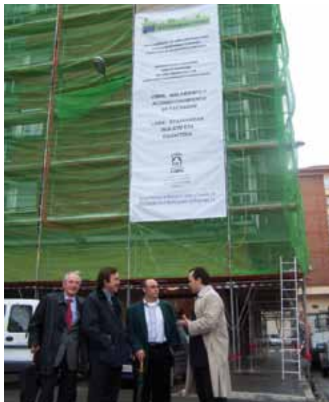
Visita de obras de proyecto piloto Visite des chantiers du projet pilote
