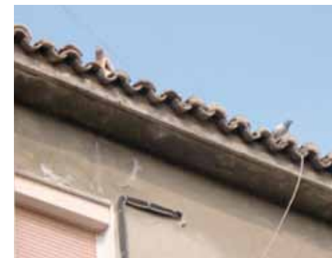
Estado de la cubierta de la vivienda dentro de un Conjunto urbano. Zaragoza État de la toiture d’un logement dans un Ensemble urbain. Saragosse
